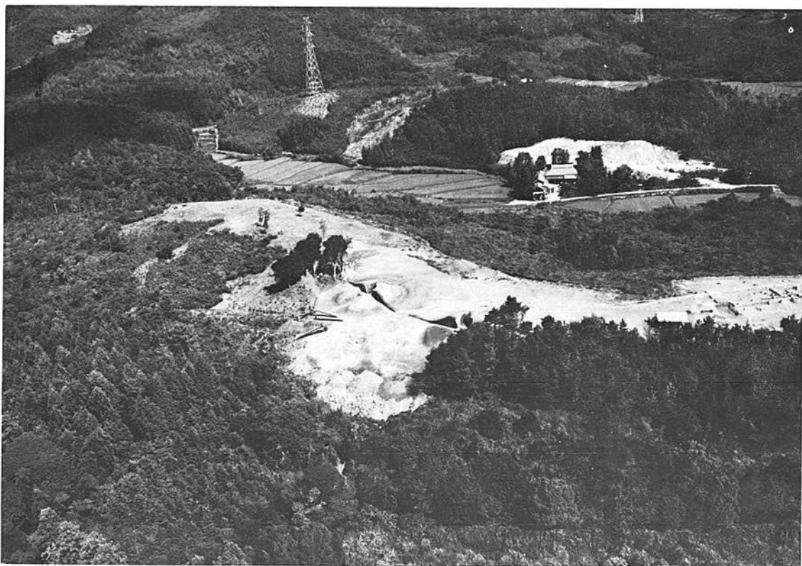
1 汐井掛遺跡航空写真 (南東から)
